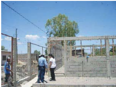
Construcción de Preescolar, Barrio Santo Domingo, Estelí
