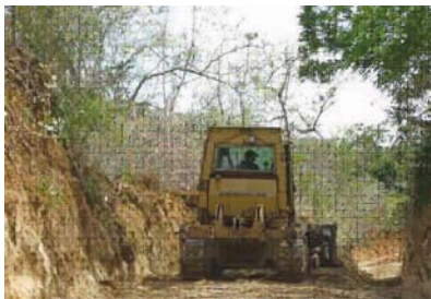
Proyecto relleno, nivelación y compactación Ostonial, San Antonio Sur.
